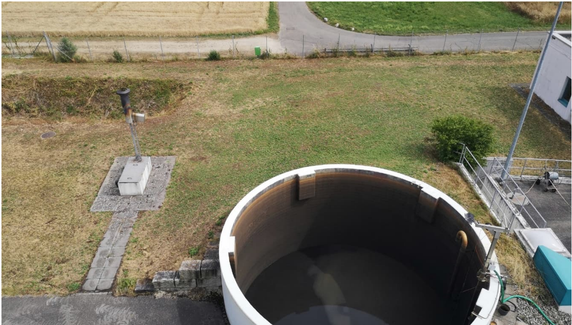
Abbildung 11: Zukünftiger Standort Gasometer / Gasraum (Sicht von Norden)
