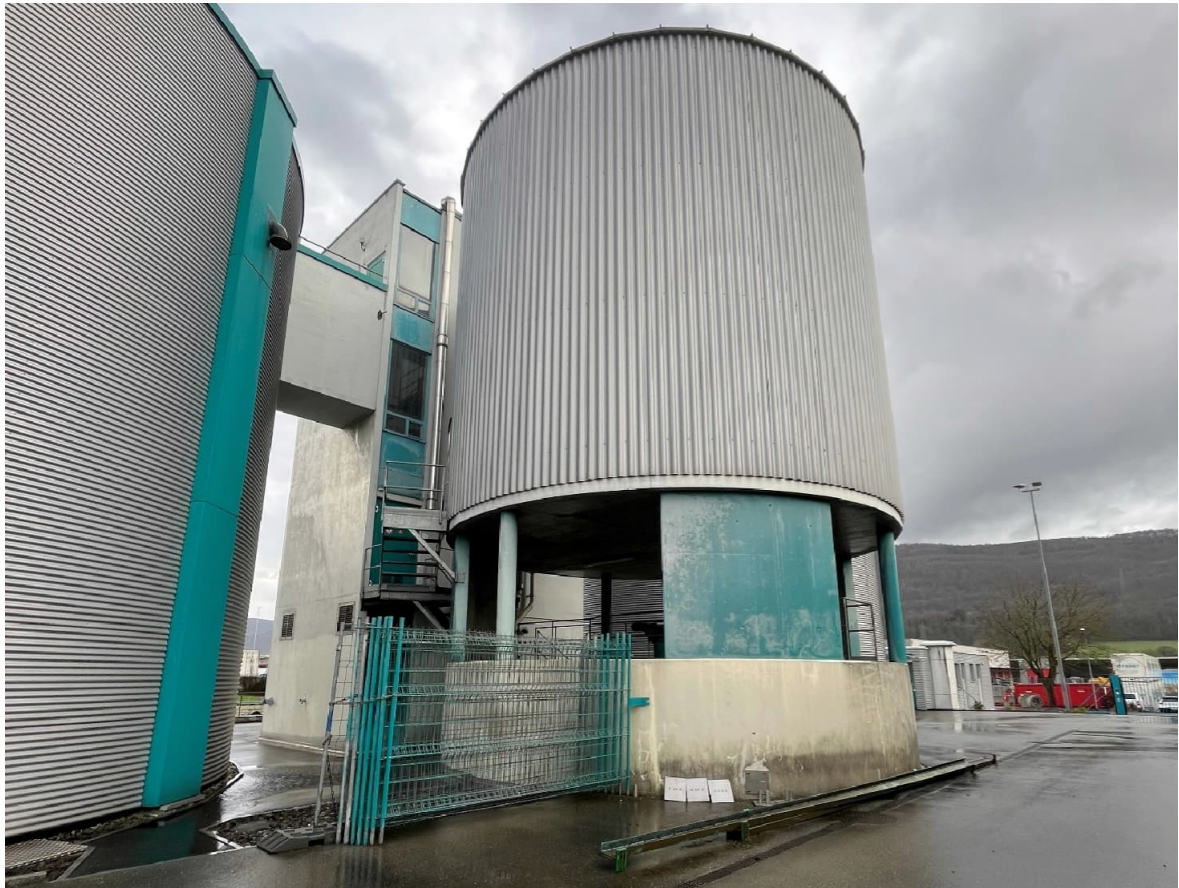
Abbildung 6: Eindicker und Gasometer im heutigen Zustand.
