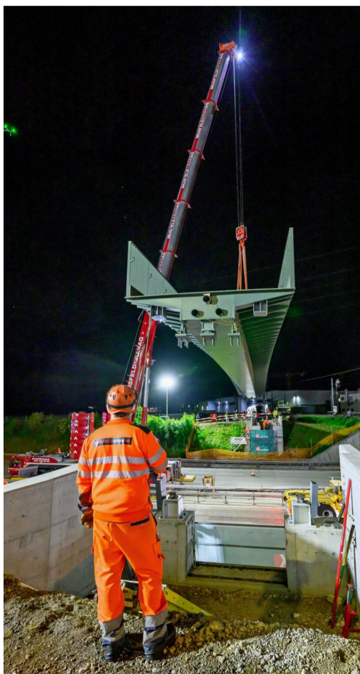
Die Brücke schwebt heran und wird langsam abgesenkt.
