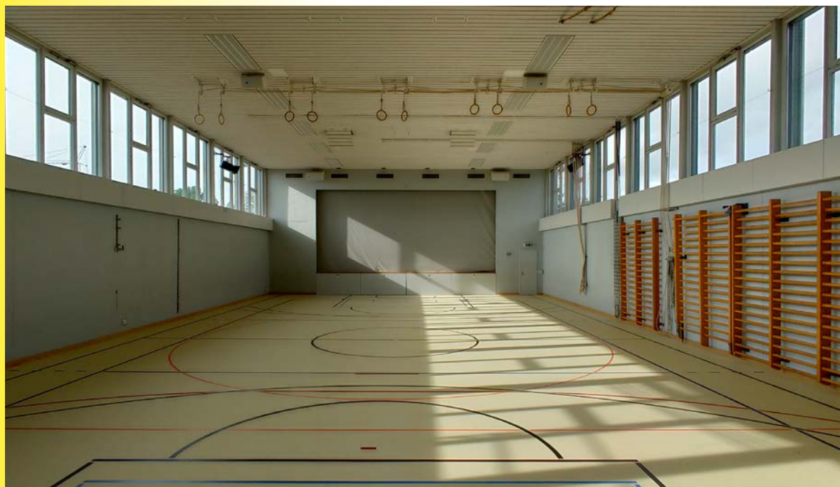
Auf den ersten Blick fällt v. a. der neue Hallenboden auf, die Turnhalle oben nach der Teilsanierung.
