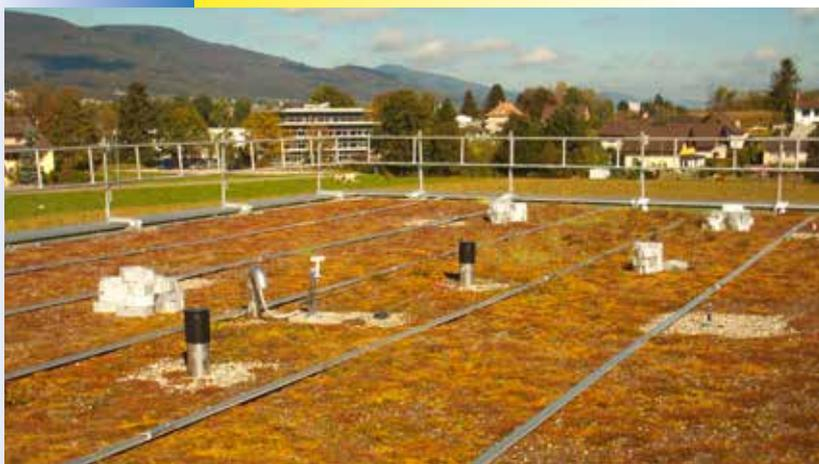
Anschliessend wurden 108 Solarmodule des Herstellers Trinasolar mit je 260 Watt Leistung montiert. Unser kleines Sonnenkraftwerk wird also 27,56 kWp produzieren können.
