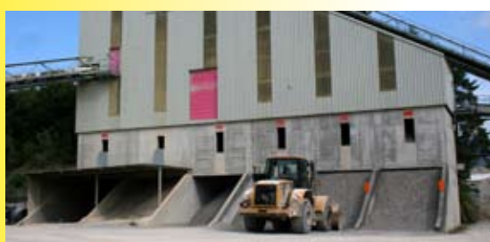
Das neue Splittwerk
