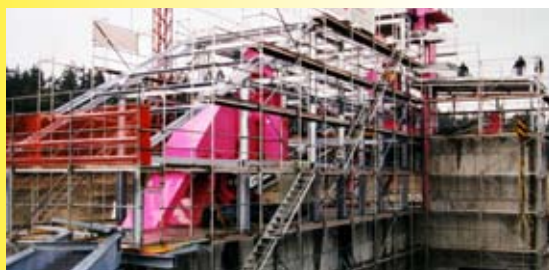
Splittwerk 1998 im Bau
