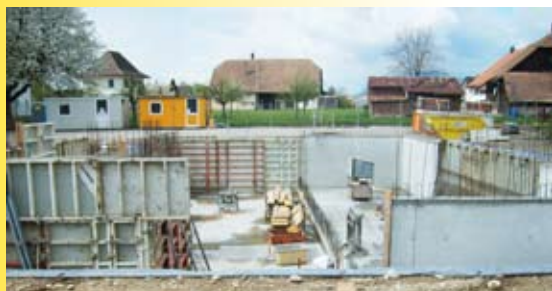
Baugrube im April
